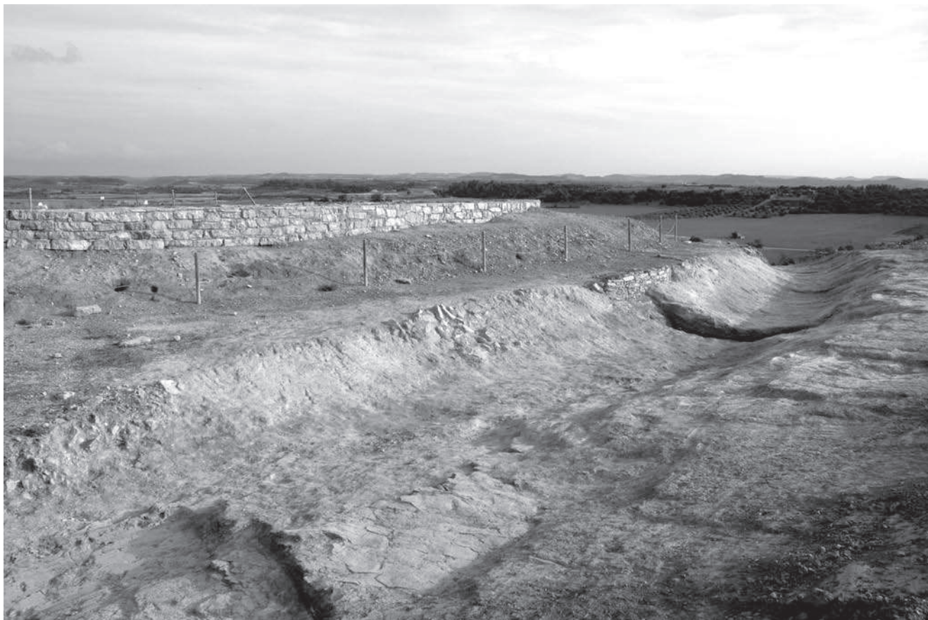
Figura 4. Vista del sector central del fossat des del nord-oest.
